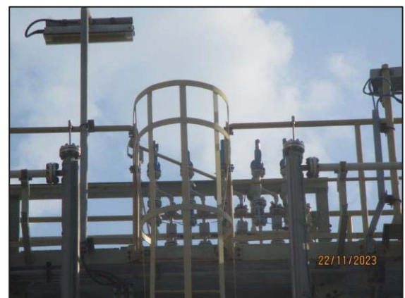
รูปที่ 3.50 Safety Valve บริเวณถังเก็บแอมโมเนีย
