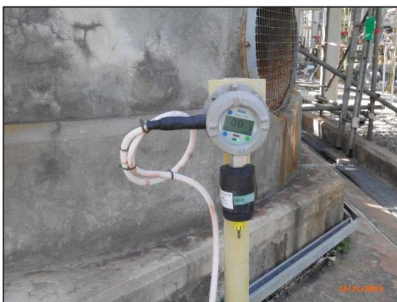
รูปที่ 3.51 Ammonia Gas Detector
