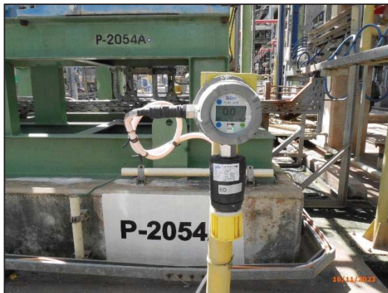
รูปที่ 3.31 EO Analyzer
