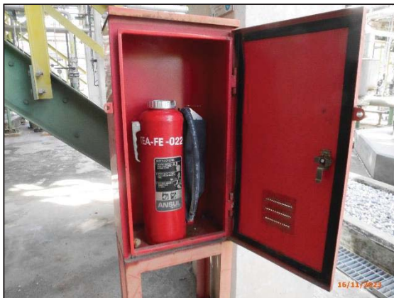
รูปที่ 3.38 ถังดับเพลิง Dry Chemical
