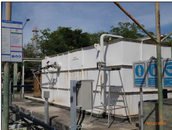
รูปที่ 3.15 Oil-water Separator (CPI)
