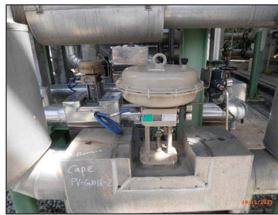
รูปที่ 3.4 Flow Controller
