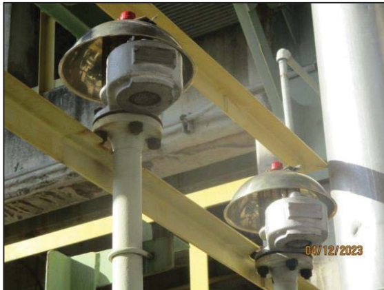
รูปที่ 3.47 Pressure Safety Valve
