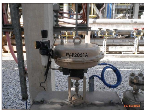
รูปที่ 3.56 Pressure Flow Control Valve
