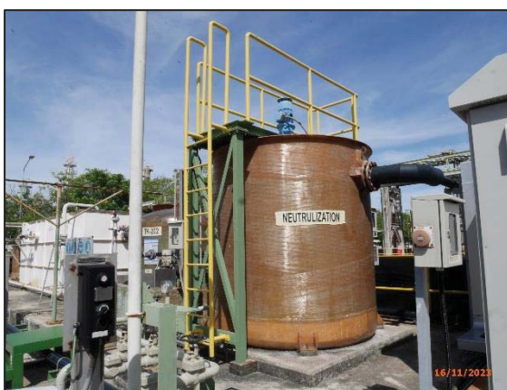
รูปที่ 3.3 บ่อ Neutralization (TK 201)
