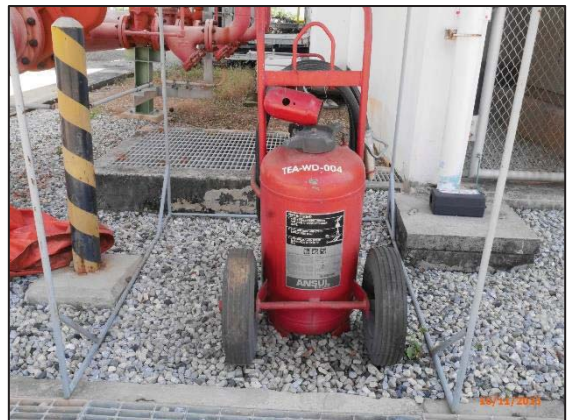
รูปที่ 3.39 ถัง Wheel Dry Chemical
